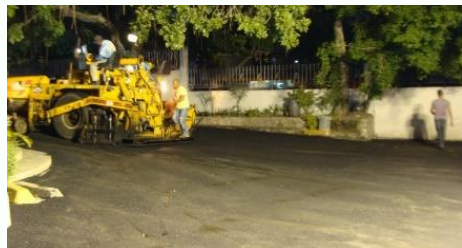
Reasfaltado en el campus principal.
