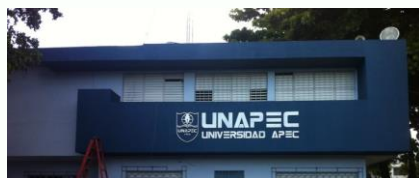
Remozamiento de la planta física del campus III.
