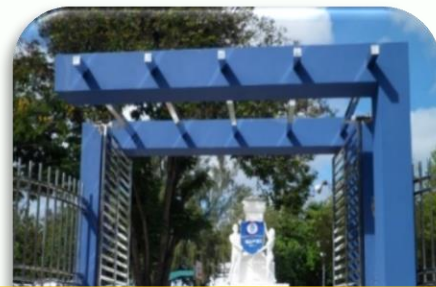
MANTENIMIENTO GENERAL PLAZA MONUMENTAL CAMPUS I
